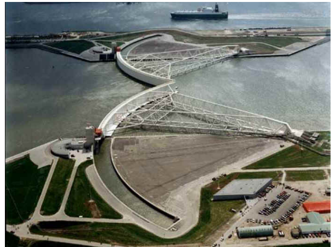
Fig. 1. Barrage anti-tempête mobile : les treillis ont les mêmes dimensions que la tour Eiffel à Paris
